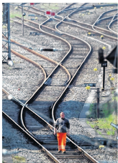
Am Hauptbahnhof beginnen heute umfangreiche Gleisarbeiten. BILD: DPA
