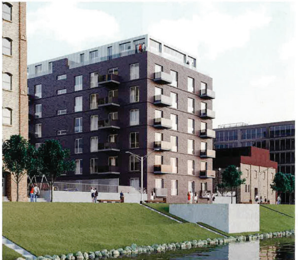
Die architektonische Harmonie des historischen Stadtteils wird vom Neubau nicht beeinträchtigt Abb.: Kaufmannmühle GmbH & CO. KG
